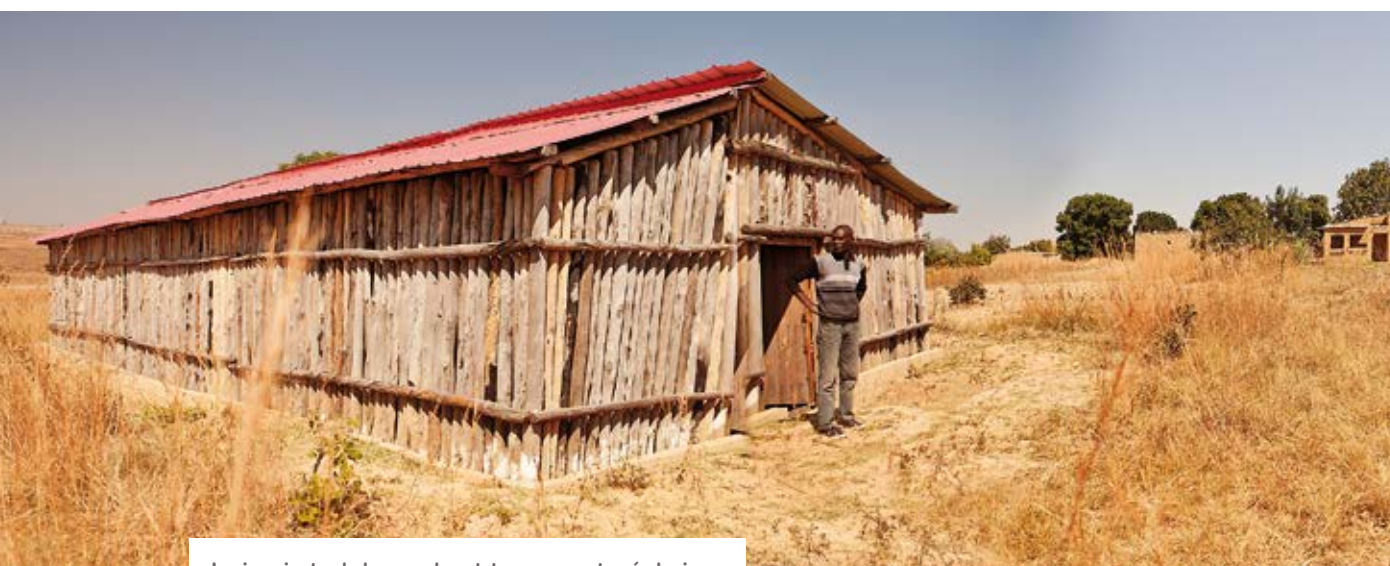
Luciano junto al almacén de patatas que construyó el mismo
