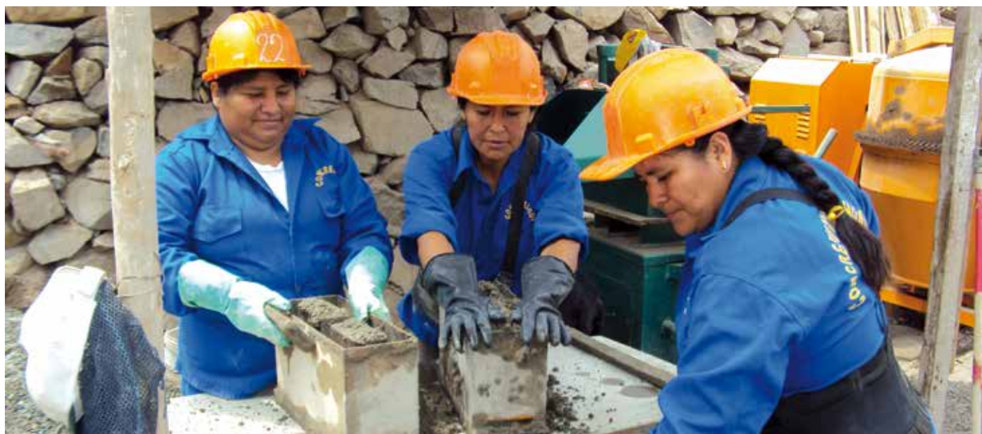
Organización de Base dedicada a la producción de cemento o concreto en Lima (Perú). Fotografía: Proyecto SUMA.
